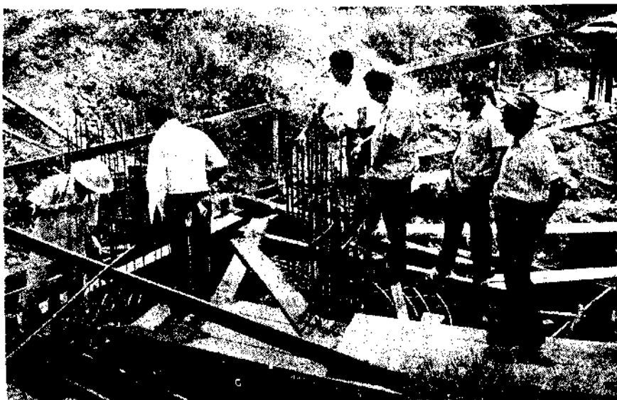
Controle van de bewapening van de „Minaret-fundering”. Van rechts naar links op de foto de heren: M.A. POESA (aannemer); Ir. N. ATAPELLAH (voorz. Bouwcommissie); Ir. E. NOERMOHAMED en Ir. G.D. SOERDJOESING (techn. Adviseurs).
